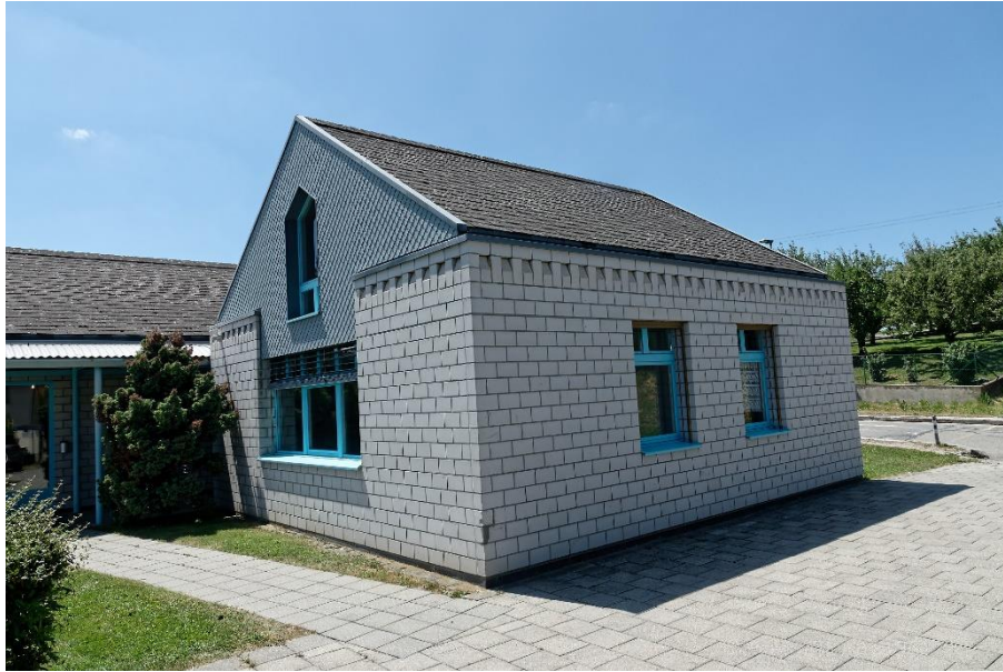
Figure 27 : Dépendance sur l'abri PC (ancien bureau postal), angle Nord.
