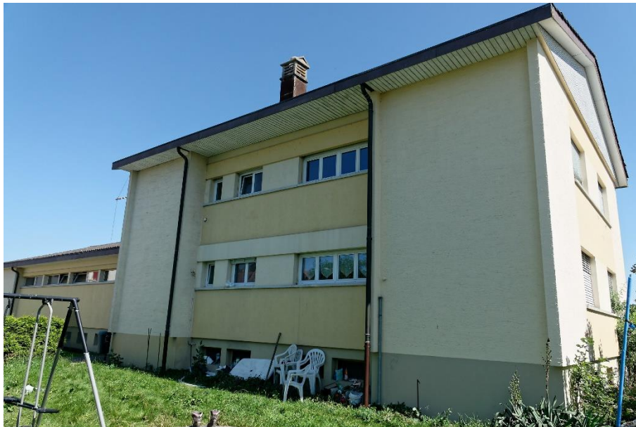
Figure 33 : Façade Ouest (appartements)
